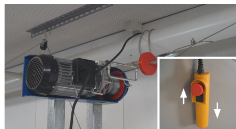
2900546 Электромотор для централизованного открывания навесов
